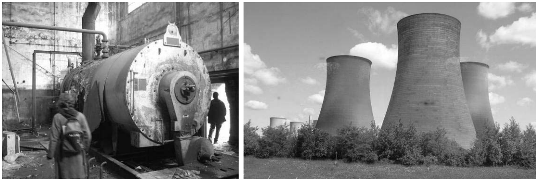
CALDERA Y TORRES DE ENFRIAMIENTO equipos comunes para provisión de servicios auxiliares
